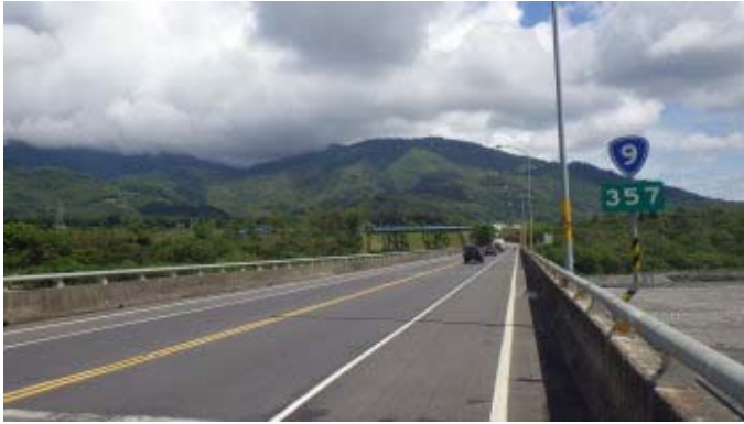
〔台9線357K〕上的鹿鳴橋水泥橋
