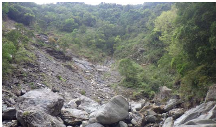
左側山壁有大面積的坍塌面
