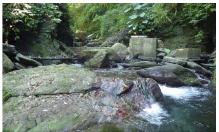
水泥攔水設施
