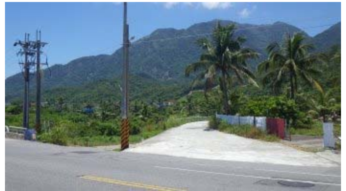
左轉 進入 八邊橋 末端的產業道路
