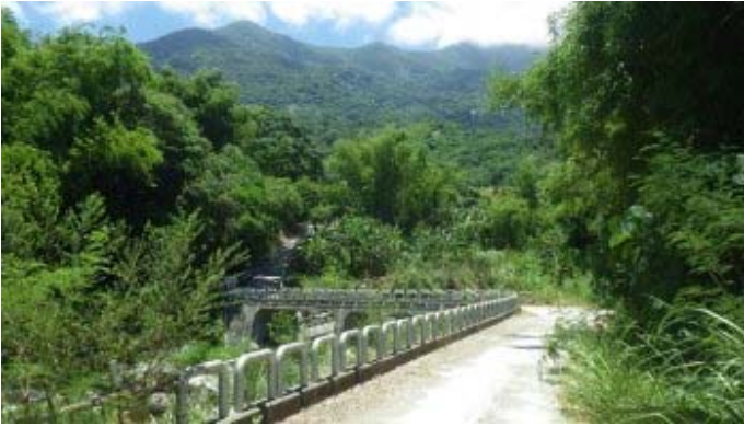
產業道路橫跨八邊溪的小水泥橋
