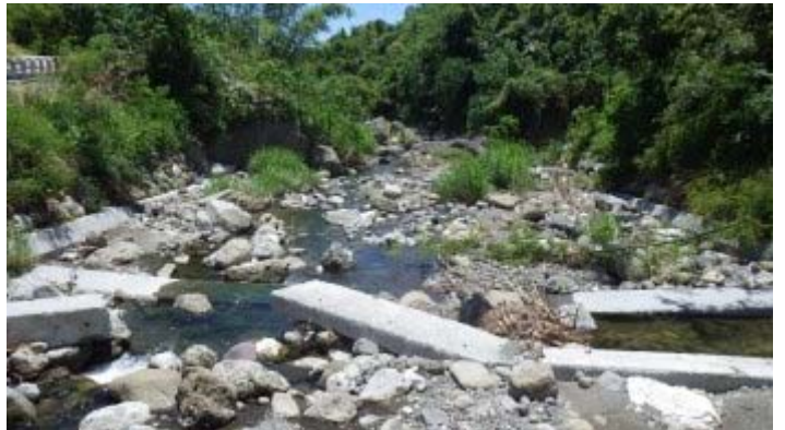
水泥橋下八邊溪下游溪況
