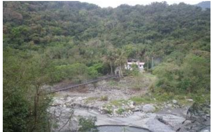
左側可俯看吊橋及〔大南發電廠〕
