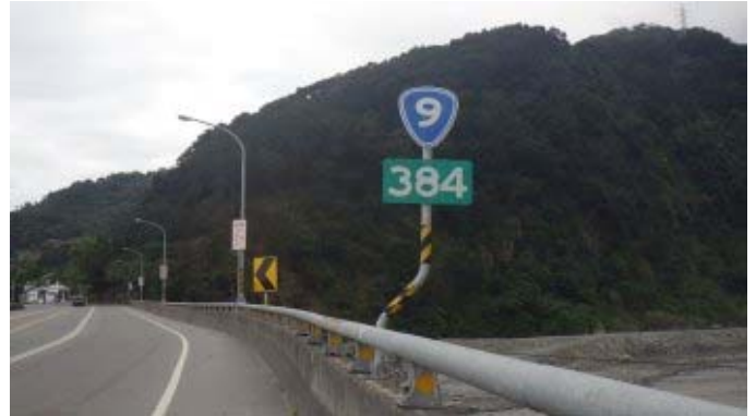
〔東園橋〕位於台九線 384K 處
